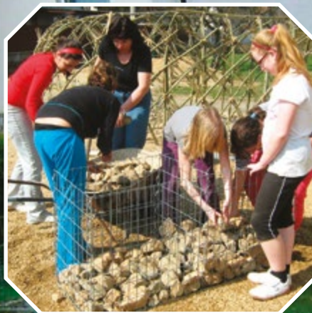
Budování gabionového posezení
